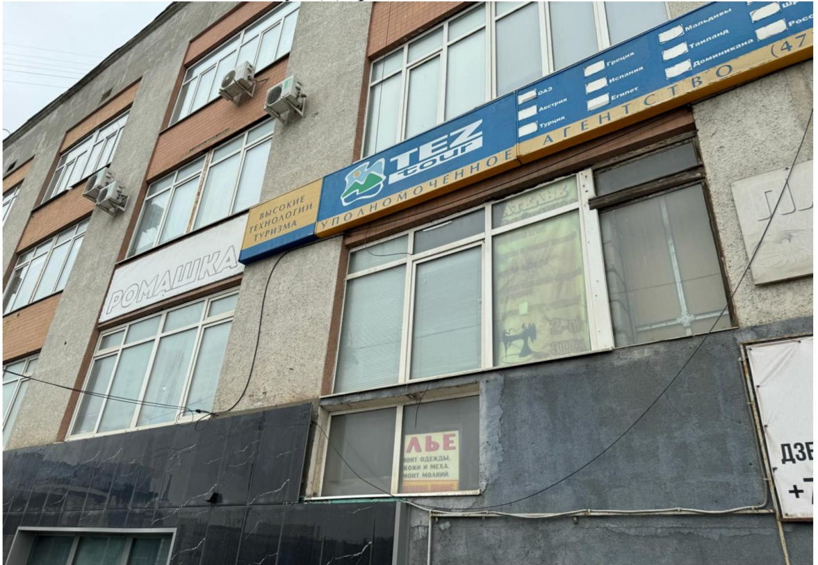
ул. Дзержинского, д. 19
